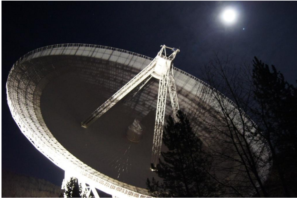
Figuur 6: De radiotelescoop met de 100-meter schotel van het Max Planck Instituut voor Radioastronomie in Effelsberg, in de Duitse Eifel. Dit instrument is geschikt voor het meten van frequenties tussen 1 GHz en 80 GHz.
